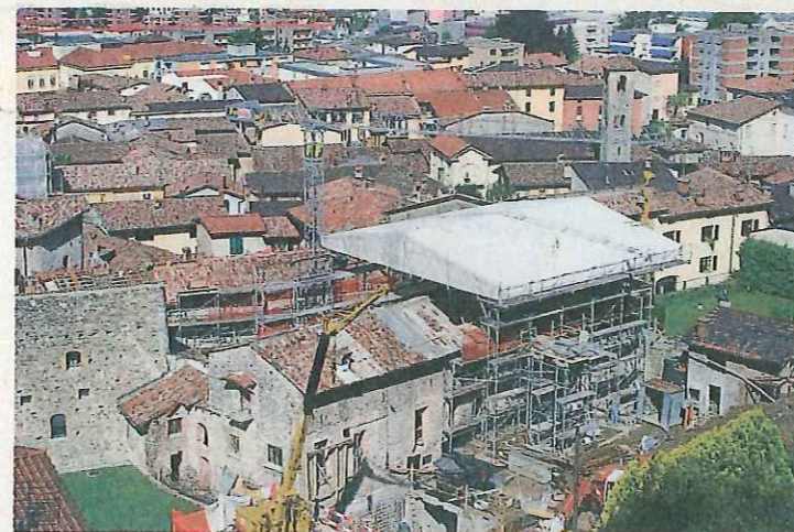
I lavori di ristrutturazione di Palazzo Busioni a Mendrisio.
